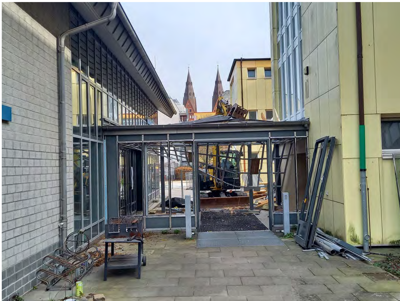
Bisweilen gehen dem Neubau auch der Abriss gar nicht mal so alter Gebäude voraus, so wie hier bei der Heinrich-Wolgast-Schule in St. Georg (Foto: M. Joho)
