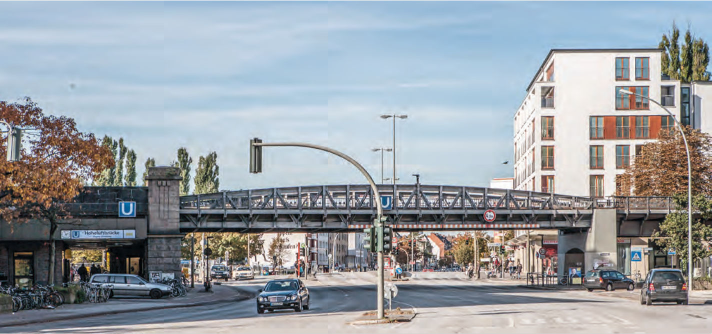
Bild 05 – U-Bahnbrücke der U3 und dahinter die Bushaltestelle des M5 auf der leicht erhöhten Hoheluftbrücke über den Isebekkanal
