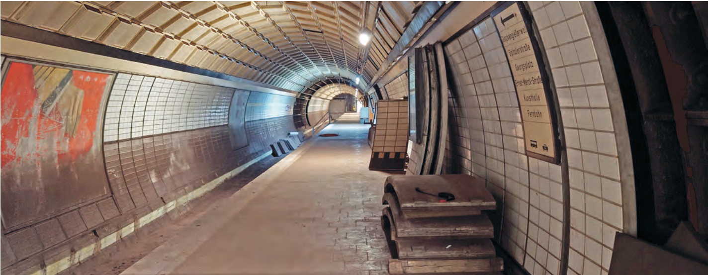
Bild 04 – Künftiger U5-Bahnsteig Hauptbahnhof Nord in Fahrtrichtung St. Georg, von 1965 bis 1968 auf Vorrat gebaut
