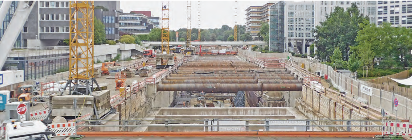
Bild 03 – Baugrube der U5 im Überseering von Sengemannstraße bis Stadtpark mit Haltestelle City Nord, 24 Meter tief
